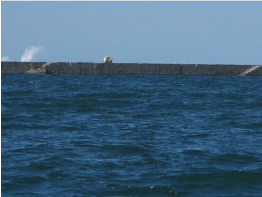
Bloc d'enrochement (45 tonnes) soulevé par la mer lors d'une tempête de février 2017...
